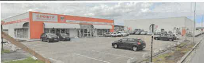
Parcelles AV 133/197/198/199 : local pro, commerce de matériaux « point p », 3 025 m 2
