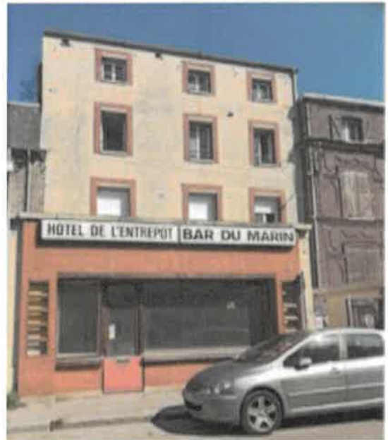
Parcelle AS 13 : immeuble mixte, 419 m 2 .
